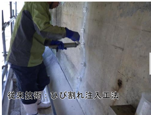
図-3 新技術の一例（ひび割れ補修の新工法）
