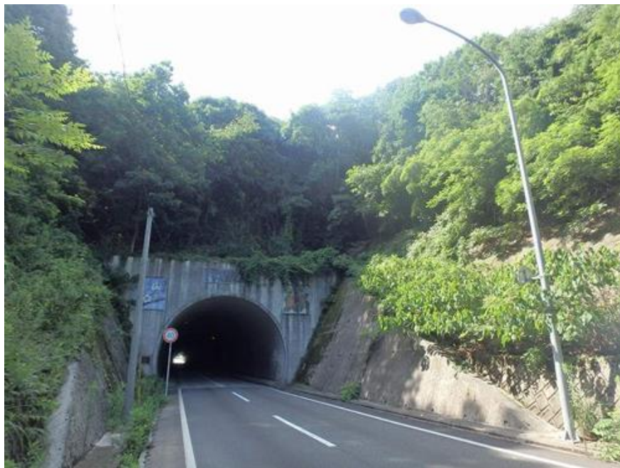
写真-1 大迫トンネル
