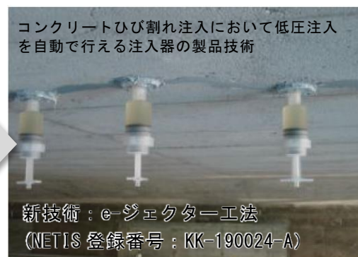
図-3 新技術の一例（ひび割れ補修の新工法）
