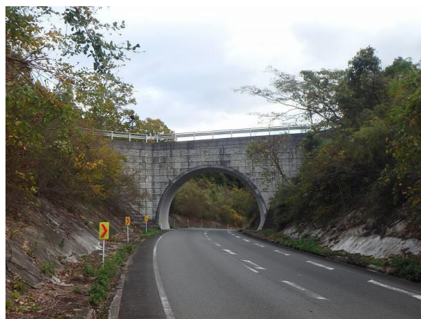
写真-2 尻高カルバート
