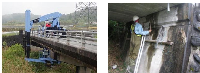
図-4 近接目視点検の様子
