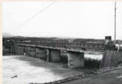
▲以前の恒久橋
