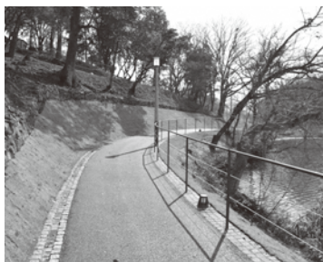
▲遊歩道工事後
