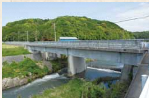
▲現在の鳴水橋
