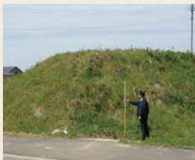
▲③現在の伏樋(吐口側)
