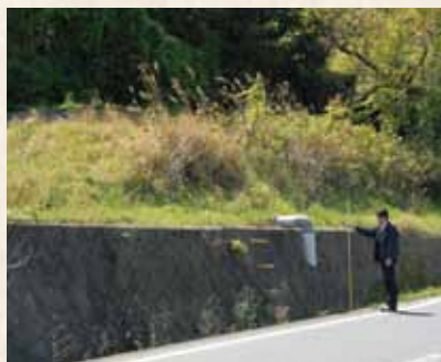
▲②現在の伏樋(呑口側)
