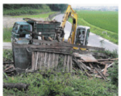
▲ポンプ小屋の解体
