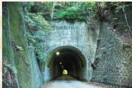
▲原井隧道(原井側)
