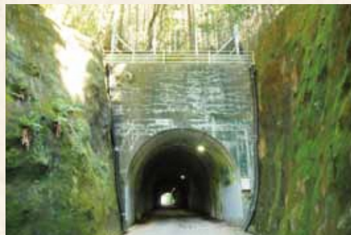
▲原井隧道(東上側)
