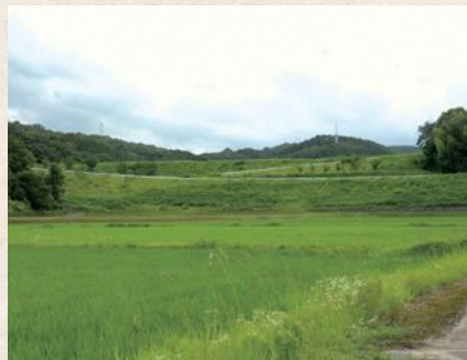
▲矢方池の堤体
