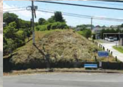
引き込み線の盛土(上部が線路敷き)
