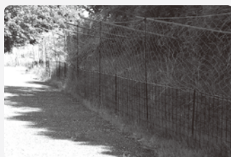
防護柵の様子
