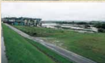
大井手(三口)井堰遠景
