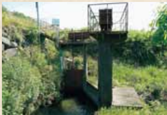
蔵尾井堰取水口 ここから水を取り入れ、唐原地区にある水田の灌漑用水を賄っている。
