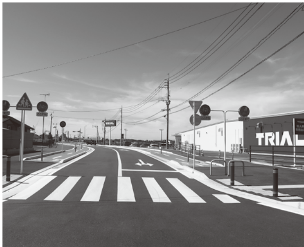
▲垂水・大ノ瀬線道路改良工事
