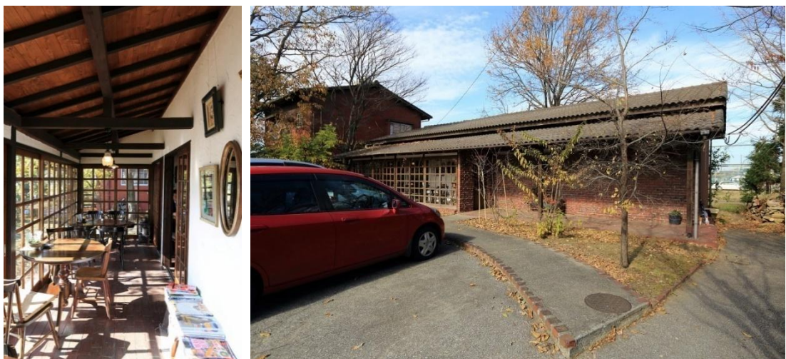
煉瓦壁が組み合わされた木造切妻カフェ（中津市）
