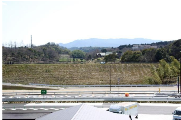
上毛 PA(下り方面)より、大池公園を望む
