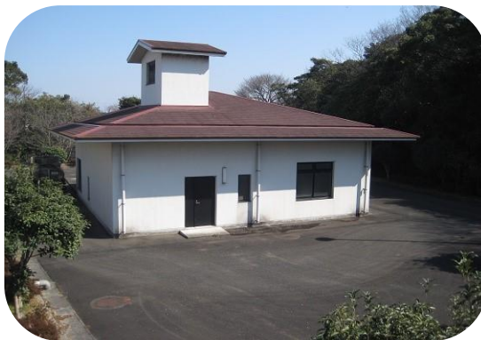
ハツ並・吉岡排水処理センター
