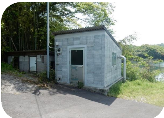
宇野ダムポンプ室 1 号
