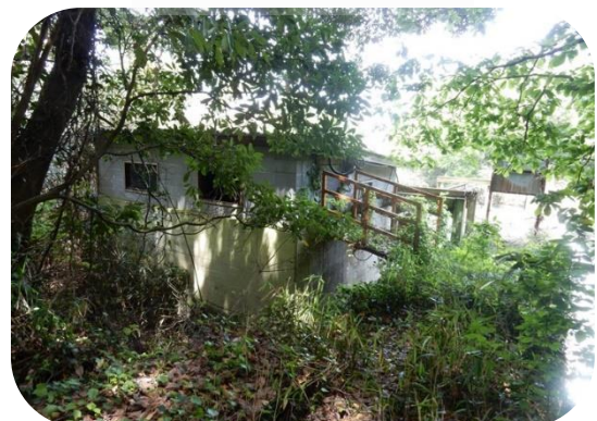
宇野ダムポンプ室 2 号
