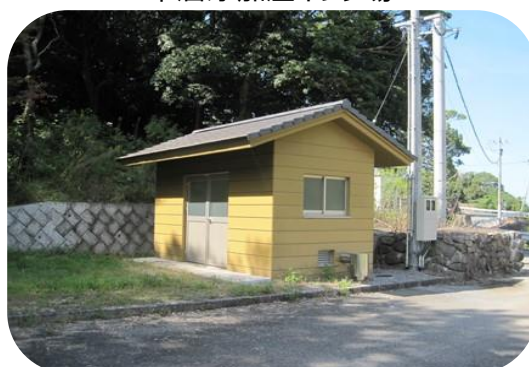
下唐原加圧ポンプ場
