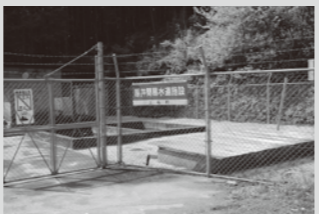
▲原井簡易水道施設
