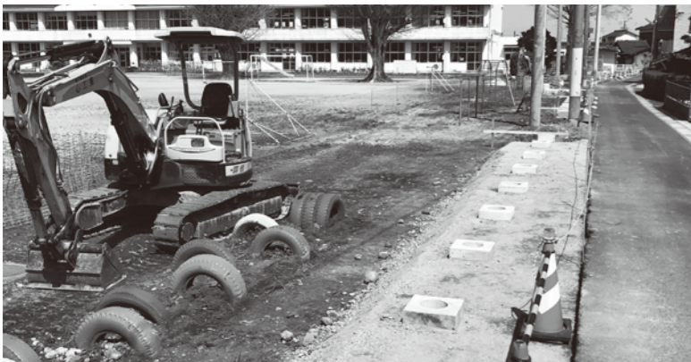
▲南吉富小学校ブロック塀工事
