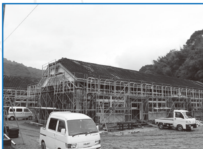
工事中の旧西友枝小学校校舎 (西友枝体験交流センター)
