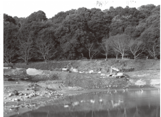
▶造成中の大池公園たまり場
