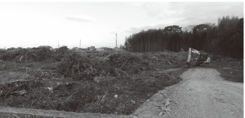
▲伐採・伐根工事の成恒工業団地予定地
