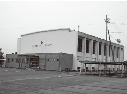
▲上毛町農業者トレーニングセンター
