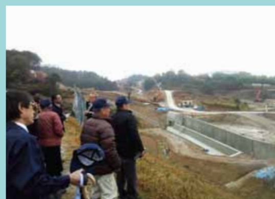
高速道路建設中(PA付近)の工事現場説明
