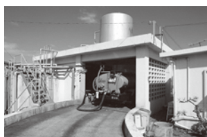
築40年を超える吉富町と共同処理しているし尿処理施設(吉富町)
