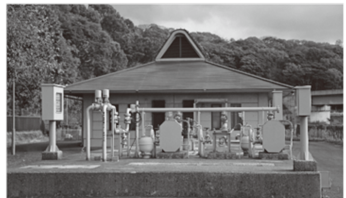
▲住民145戸が接続している土佐井排水処理センター
